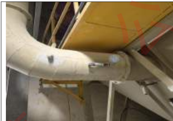
FQ-41423L (现场空间受限无法设置规范的采样口)
