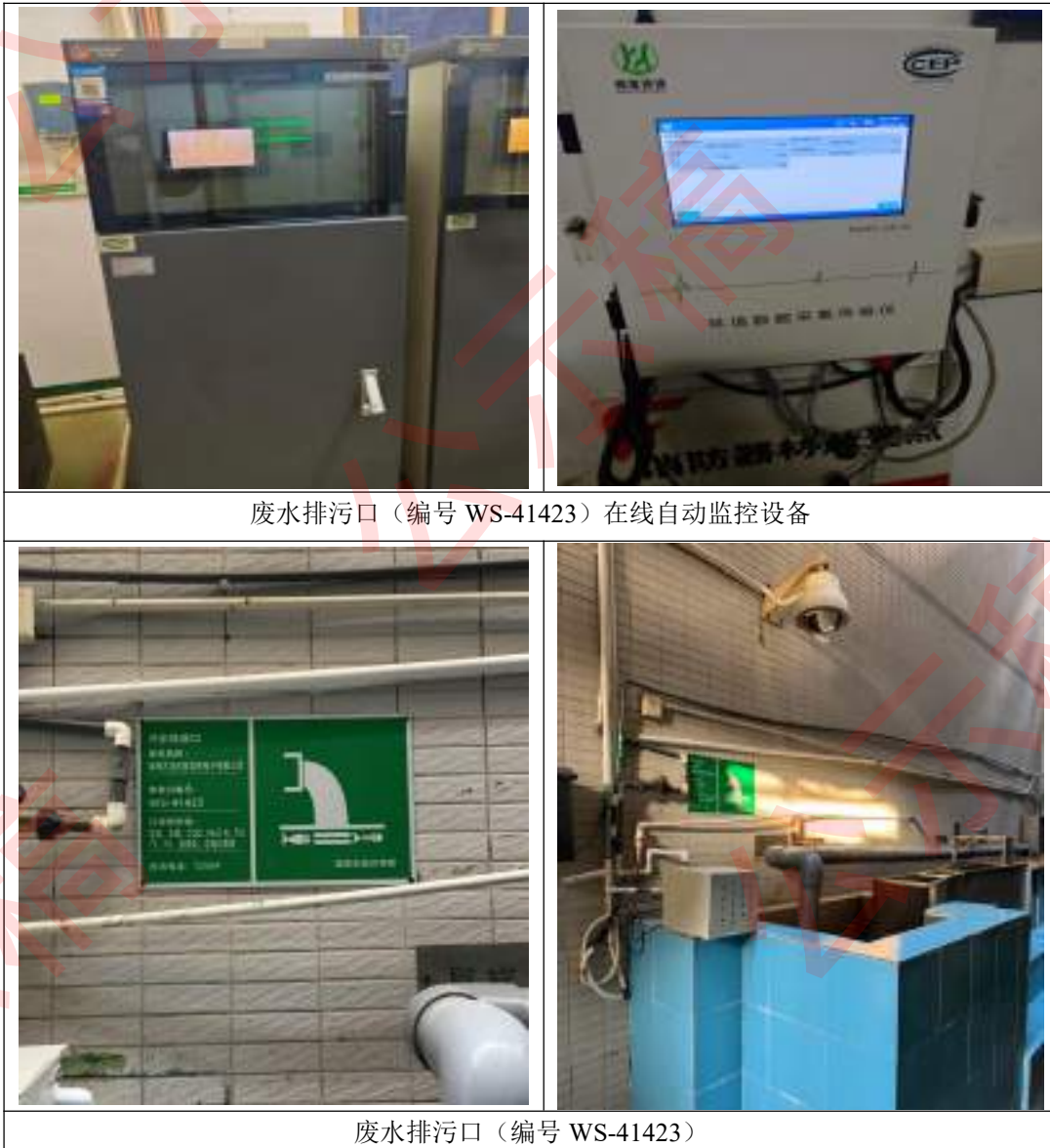
图 4.2-4 生产废水排污口和在线自动监测设备设置情况
